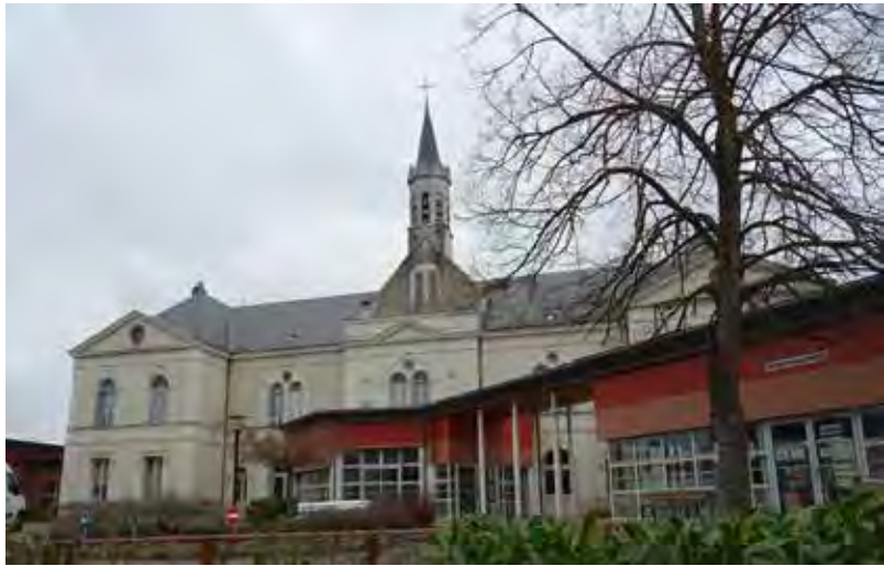
4-Le Bâtiment historique de l'EHPAD
